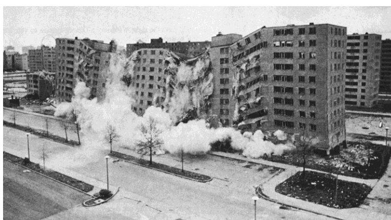
Figura 1. Destrucción del complejo residencial Pruitt-Igoe. 16 de marzo, 1972. Representación de la muerte del “funcionalismo”.
